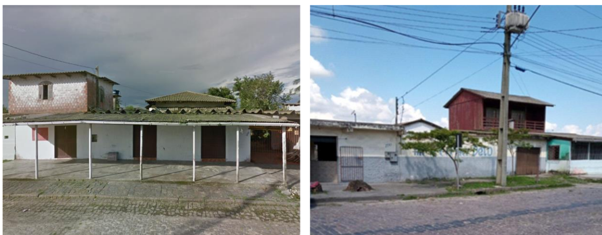
Figura 65: Edificações de uso misto na Rua Xavier da Silva. Fonte: Pesquisa de campo (EnvEx, 2021).
