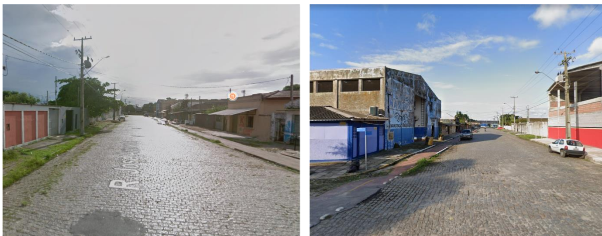
Figura 110: Início e final da Rua José de Azevedo. Fonte: e Google Street View (2019).
