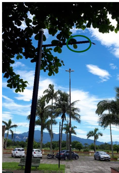
Figura 41: Luminária faltando no espaço lateral do Santuário (círculo em verde na foto).
