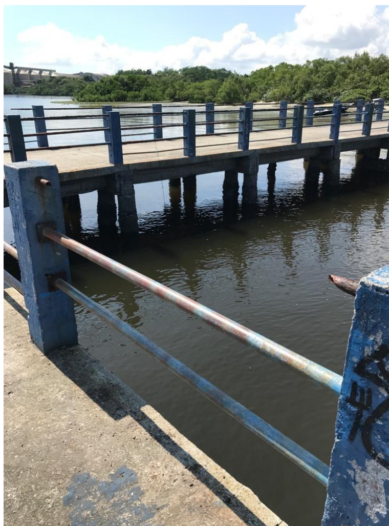
Figura 32: Grade de proteção no píer do Rocio destruída. Fonte: Pesquisa de campo (EnvEx, 2021).
